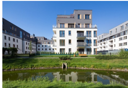
Ostoja-Wilanów (etapa 6.A, edificio B4). Fecha de entrega: Diciembre de 2015. N° de unidades: 136 viviendas y un local comercial (9,217 m 2 ).
