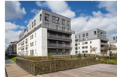
Ostoja-Wilanów (etapa 6.A, edificio C2). Fecha de entrega: Noviembre de 2016. N° de unidades: 120 viviendas (12,531 m 2 ). Prevendido: 99% (a 30 de septiembre de 2017).
