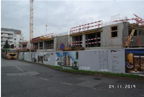
Área de ejecución de obras de Innova Concept, Wrocław.
