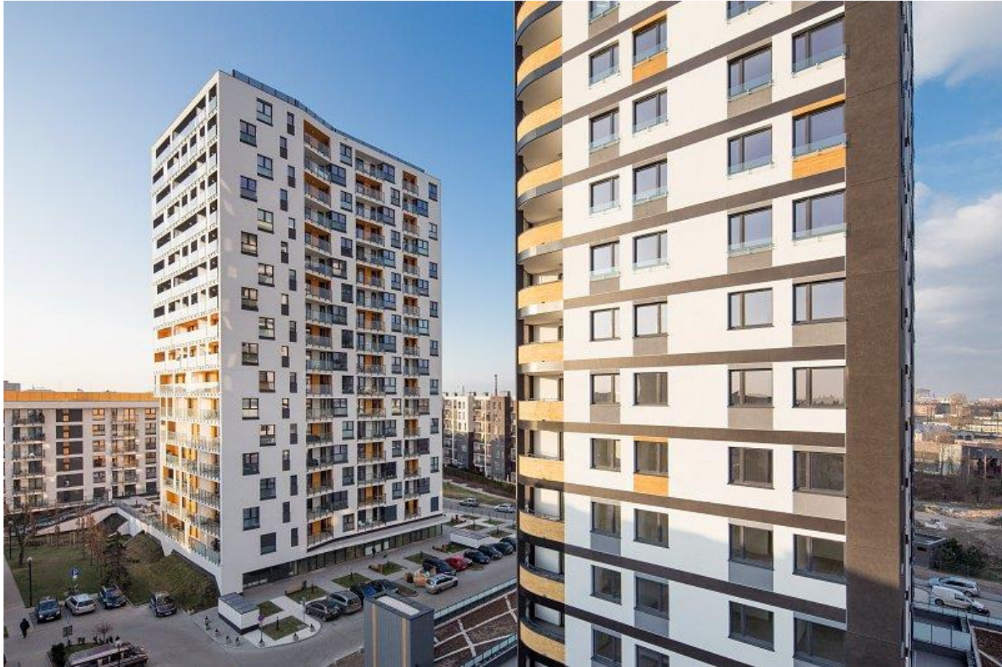
De izquierda a derecha: edificios 6.4, 6.5 & 6.3 de Apartamenty Innova, Wrocław.
