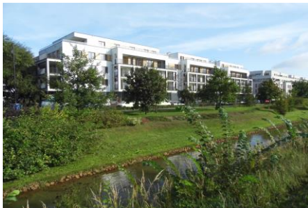
Ostoja-Wilanów (etapa 8, edificio B2). Fecha de entrega: Octubre de 2017. Nº de unidades: 43 viviendas y 3 locales comerciales (4,981 m 2 ).
