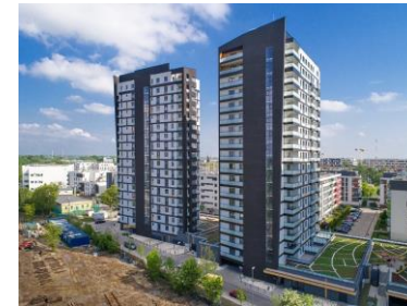
Apartmenty Innova III (edificios 6.2 & 6.1).
