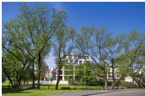
Ostoja-Wilanów (etapa 7, edificio C4).
